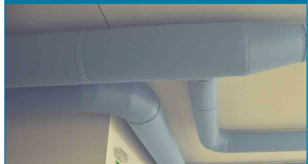
Conduits de transport de l'air
