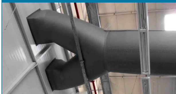
Raccordement du diffuseur à l'entrée d'air
