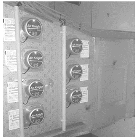
Exemple d'installation dans la gaine
