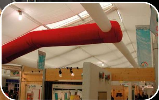
La diffusion de l'air est réalisée à travers des (micro) perforations à diamètres variables.
