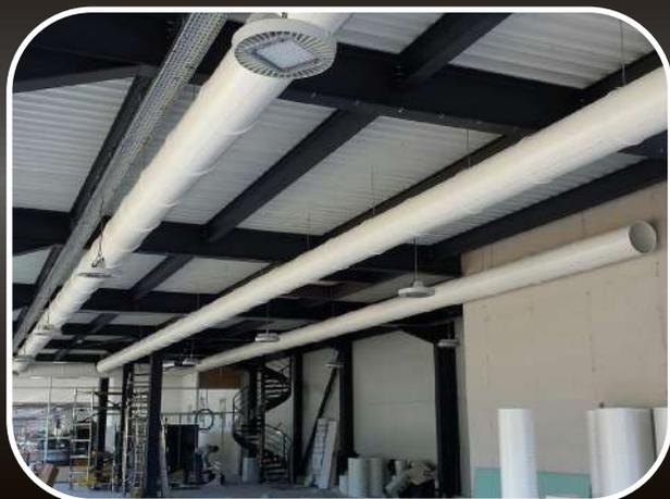
Grâce au contrôle précis de la vitesse du flux en sortie, on maintient en mouvement l'air autour de toute la surface de la gaine, évitant la stagnation d'humidité qui aurait pour conséquence la formation de condensation.
